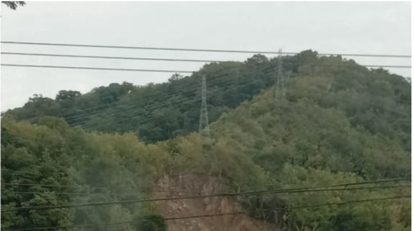
Bukit tempat berdirinya Tower Suket milik PLN mulai terkikis diduga akibat aktifitas tambang galian C
